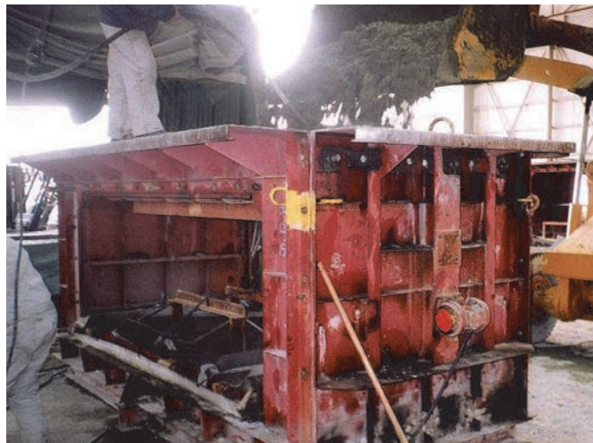
コンクリート打込み
