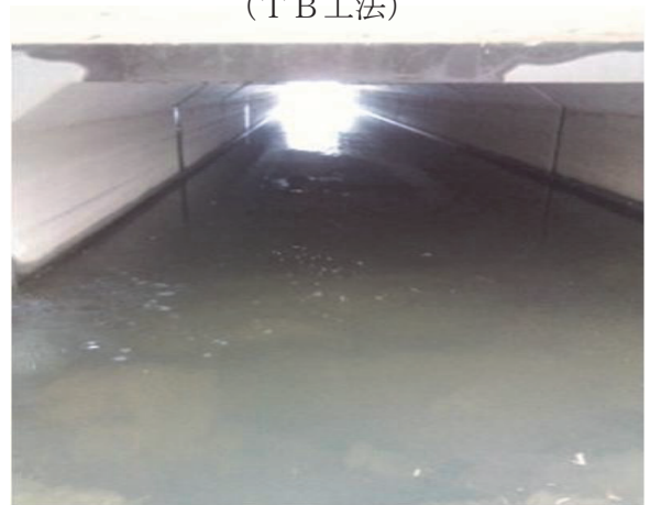
(※4) 茨城県鉾田市 BOX 1500×1500×2000mm (T B 工法)
