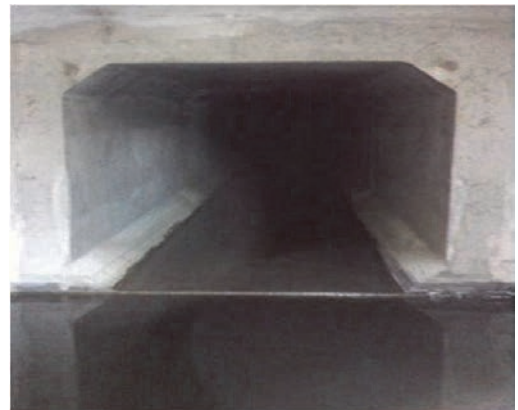
(※6) 茨城県石岡市 BOX 800×800×2000mm (T B 工法)
