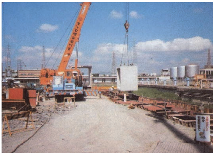
搬入及び施工
