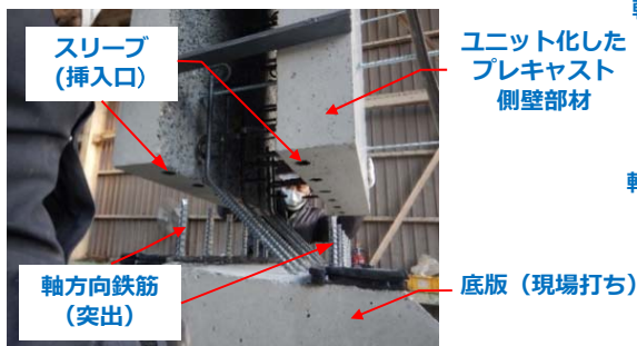
写真-2 プレキャスト側壁部材の接合状況
