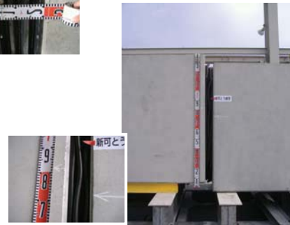
せん断変位確認試験
