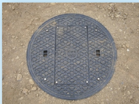
マンホール蓋タイプ (簡易型和式トイレとして使用可能)
