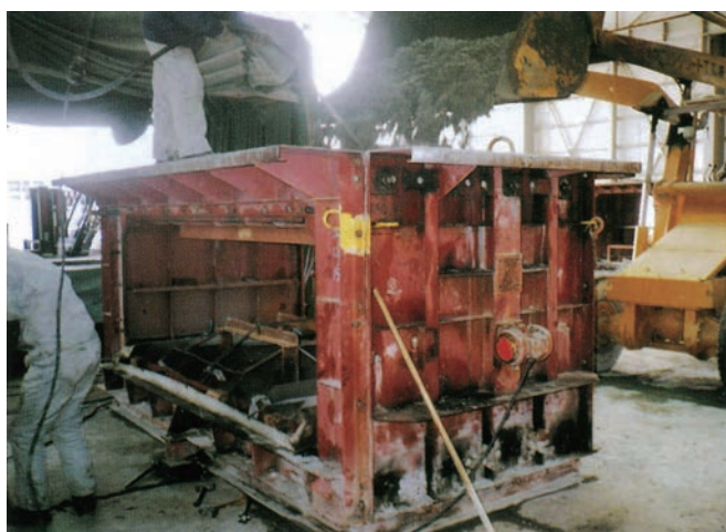
コンクリート打設
