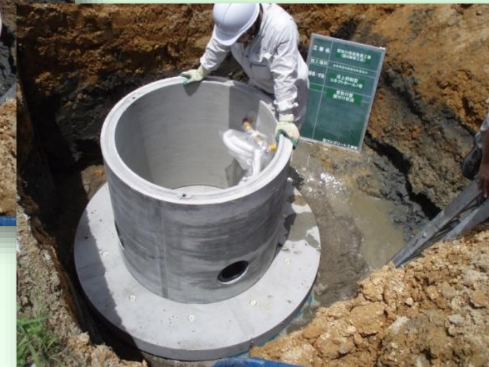
浮上抑制型コネクホール 施工事例(2)
