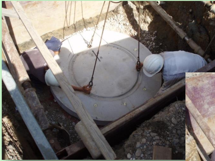
浮上抑制型コネクホール 施工事例(1)
