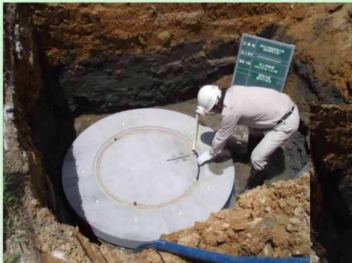
浮上抑制型コネクホール 施工事例(2)
