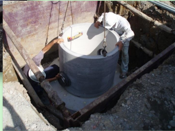
浮上抑制型コネクホール 施工事例(1)
