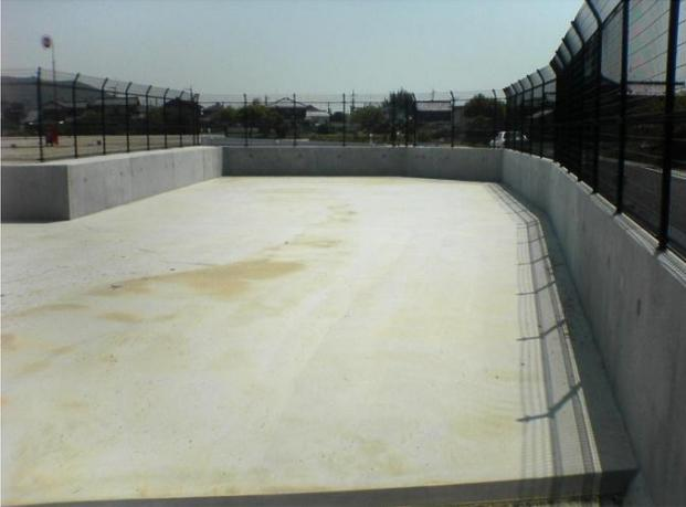
宅地造成に伴う雨水流出抑制のための雨水調整池
