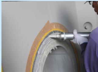
接続管との隙間にバックアップ材を挿入後、コーキングガンを用いてTBボンドを充填します。
