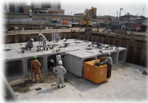
BOX型雨水貯溜槽への適用例
