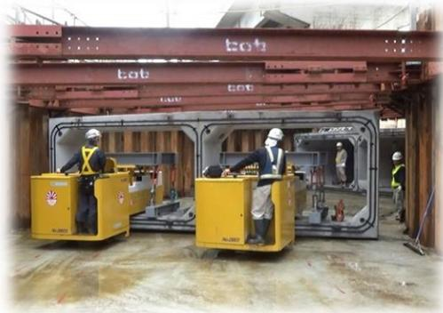
台車を2台使用した2連ボックスカルバートへの適用例
