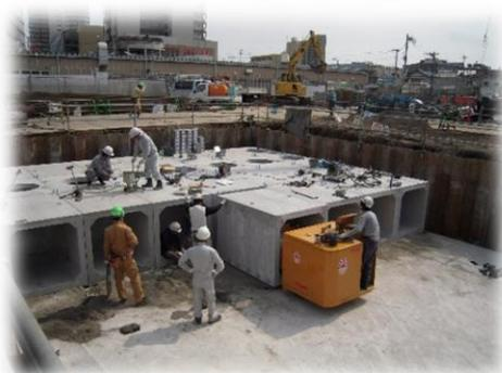
BOX型雨水貯溜槽への適用例
