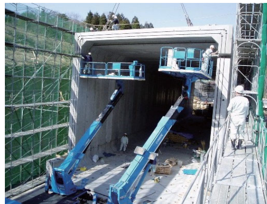
上下4分割PRCボックスカルバート 内幅9250×内高9000
