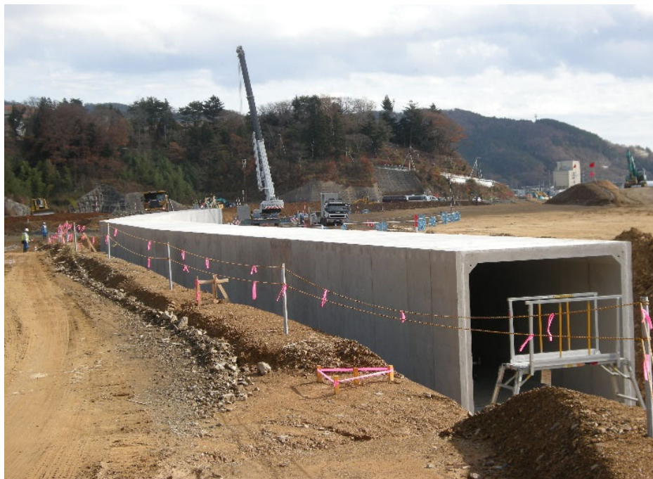
PCボックスカルバートの設置状況
