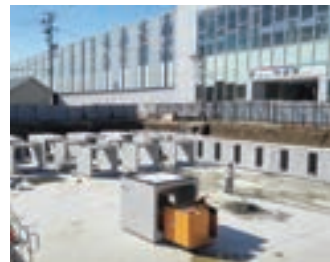
駅前に雨水貯溜槽を構築 製品を無騒音（CO 2 排出ゼロ）で搬送するECO-C・L工法
