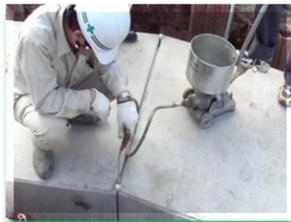
注入口より側壁部・底版部へ注入
