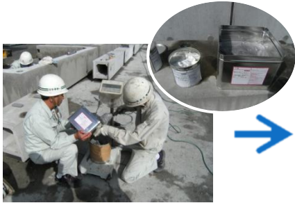
① TBボンド（コーキング用）の A剤（主剤）とB剤（硬化剤） を1：3で計量する。
