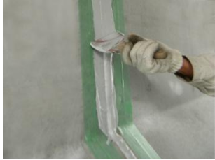
⑤ ヘラ等を用いて表面を滑らか に仕上げる。
