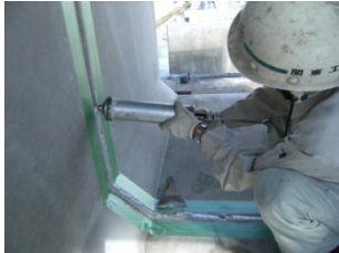
④ コーキング用のガンを使用し 加圧しながら一定速度でTB ボンドを充填する。 （プライマーは不要）
