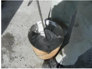
② A剤（主剤）とB剤（硬化剤） を、練りムラがなくなるまで 混ぜ合わせる。
