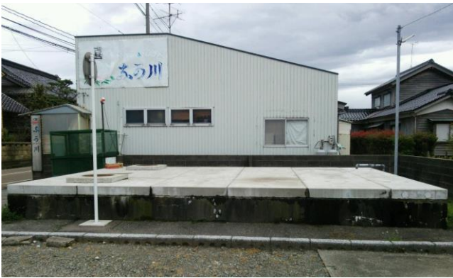
【現場打ち水槽の蓋】
