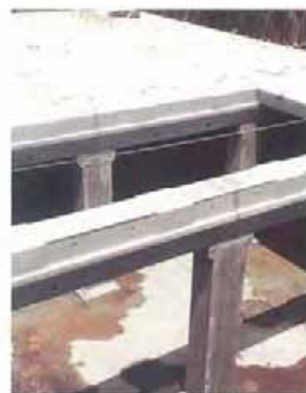
頂版スラブ据付け状況
