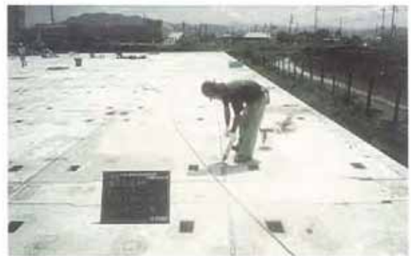
組立完成状況
