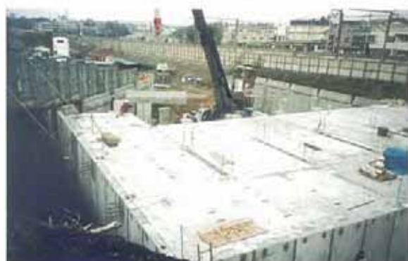
頂版スラブ据付け状況
