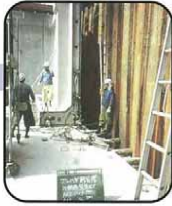
1. コーナー壁据付け
