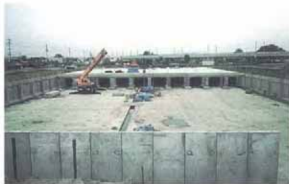
組立作業状況
