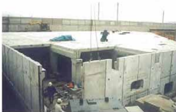
組立作業状況
