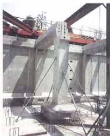
柱・梁据付け状況
