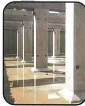
7. 底盤現場打コンクリート打設
