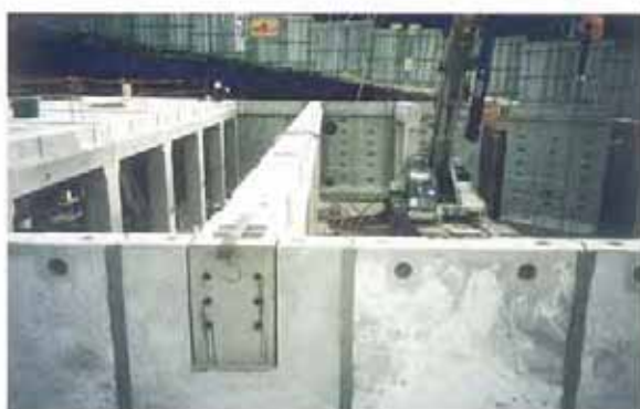
梁据付け状況
