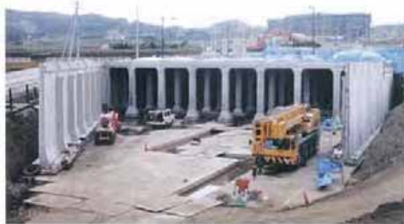
組立作業状況
