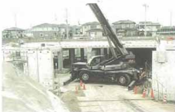
組立作業状況
