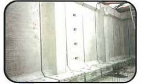
2. 中間壁・柱壁据付け
