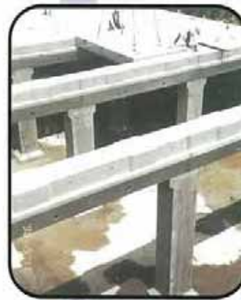
8. 頂版スラブ据付け
