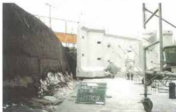
コーナー壁据付け状況
