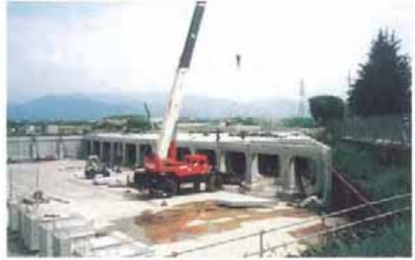
組立作業状況
