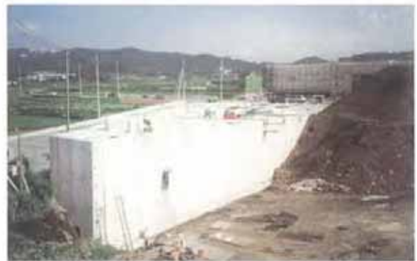
組立完成状況
