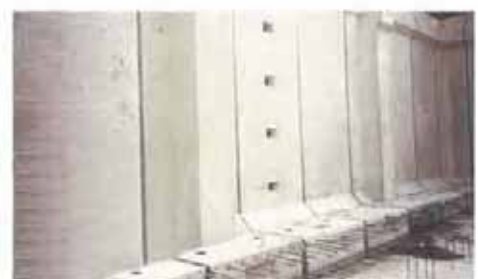
壁据付け状況
