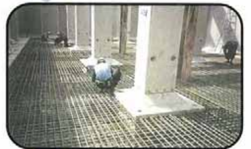
6. 底盤部鉄筋組立
