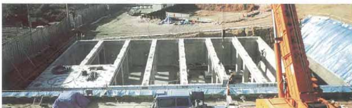
梁据付け状況
