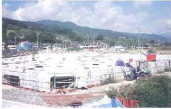
組立完成状況
