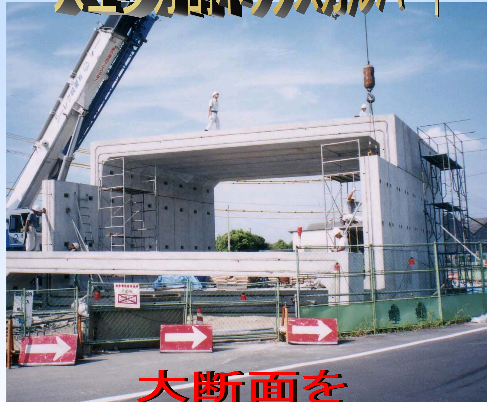
写真の大型多分割ボックスカルバート 断面サイズ：内幅9500mm×内高4900mm 平面形状：平行四辺形
