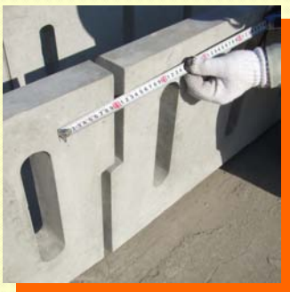
写真は、ジョイント部の隙間を20mm開けたときのカーブ付け状況（R = 50m 相当）
