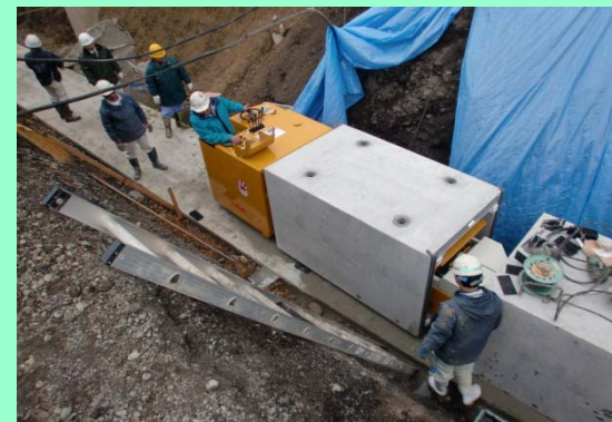
TB工法との組合せ施工
