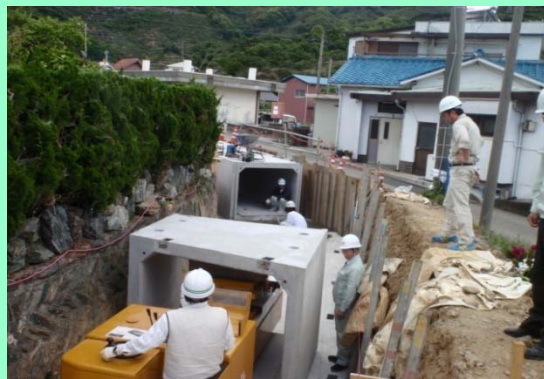
住宅地での施工（狭隘地・曲線部）
