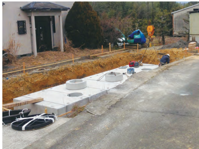
狭隘地での設置例
