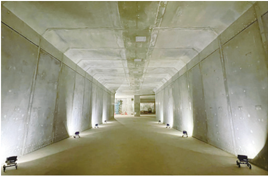
写真-4 完成写真(地下車路)
