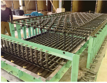
プレキャスト部材製作(側壁部材)
