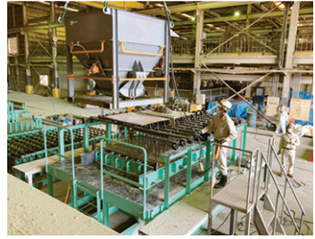
コンクリート打込み
