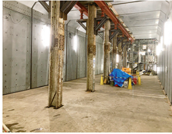
プレキャスト部材据付け完了
