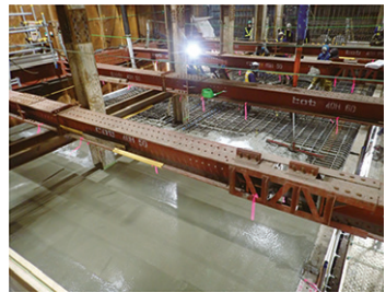
頂版コンクリート打込み
