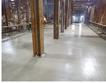
底板コンクリート打込み
