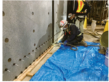
部材接合(モルタル充填継手)
