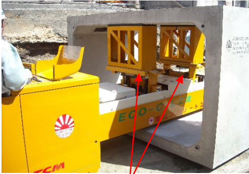
リフトアップ部
