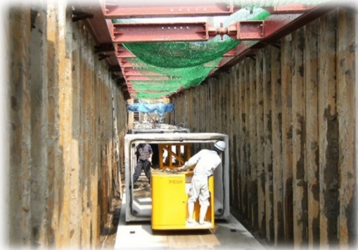
切梁が多い現場への適用例 (雨水排水) 内幅1800×内高1500
