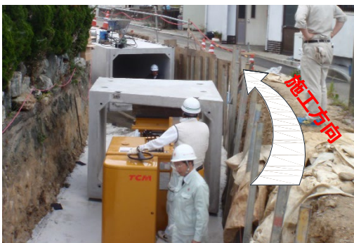
急曲線での施工状況
