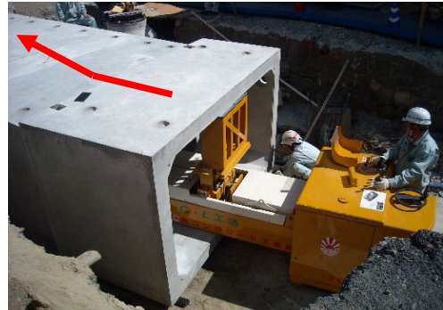
斜型製品の据え付け状況
