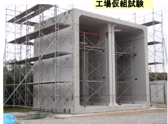
工場仮組試験
